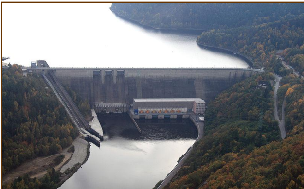
Hráz vodní nádrže Orlík
