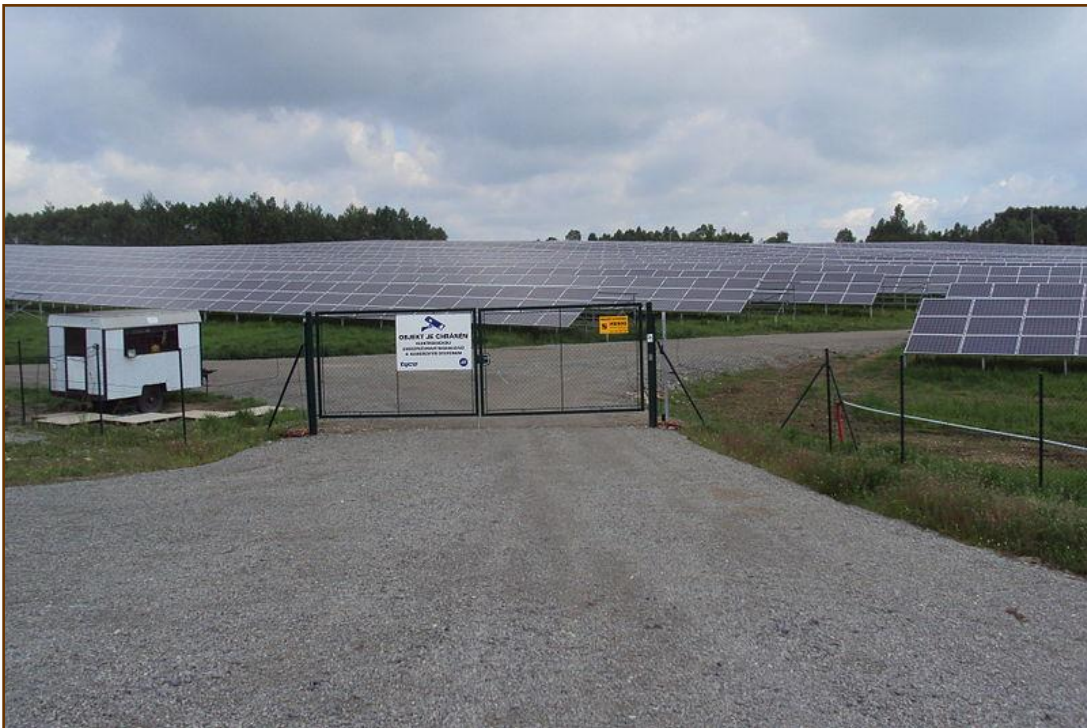
Sluneční elektrárna 5 MW u Stráže pod Ralskem
